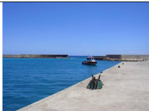
Visite du quai de Moerai
